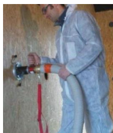
Insufflation isolante en vrac
