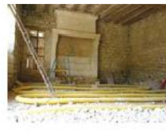
3/ Mise en place d'un drain en serpentin tous les 80 cm au cœur du hérisson.
