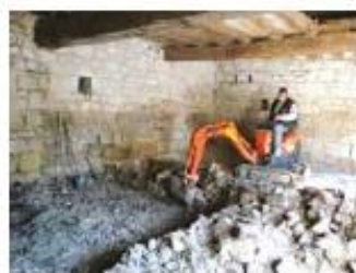
1/ Décaissement du sol existant en prenant soin de la périphérie des murs.
