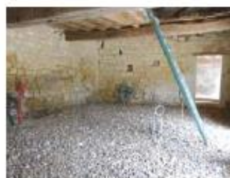
2/ Pose d'une nappe de cailloux de roches dures sur le sol naturel.
